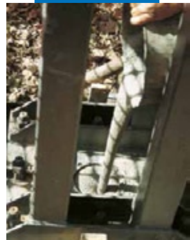
Анкерное крепление с помощью раствора Mapefill
